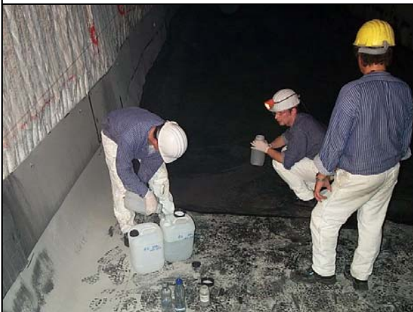
Photo 24: Probenahme aus Zwischenspeicher 658-m-SohleT(MP 27-Z)
