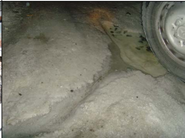
Photo 04: Zulauf aus der Strecke vor westlichem Laugesumpf 725-m-Sohle (MP 38)
