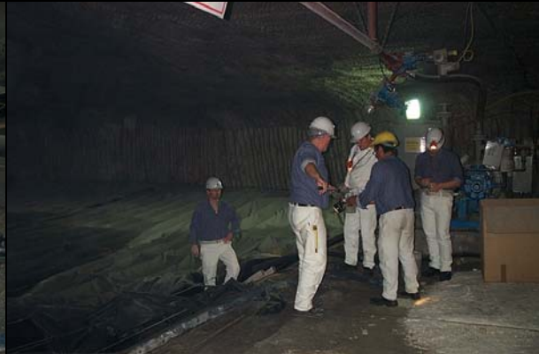
Photo 08: Probenahme SB1vo mit Schöpfgefäß
