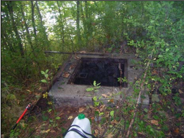
Photo 76: Speicher-Zisterne für Betriebswasser aus Brunnen Schacht 4, MP BrS4-Z
