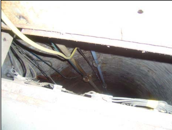
Photo 74: Steigleitung des Brunnens bei Schacht 4 (für Betriebswasser); MP BrS4-B
