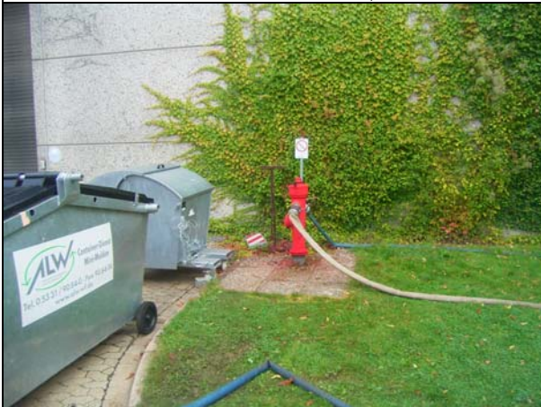
Photo 78: Hydrant für Betriebswasser vor Halle Schacht 2; MP BrS4-H
