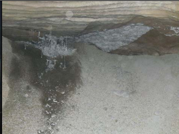
Photo 02: Tropfstelle im First der Kammer 3 auf 658-m-Sohle
